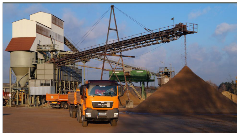
Nassaufbereitungsanlage; Foto: © Mineralix GmbH
